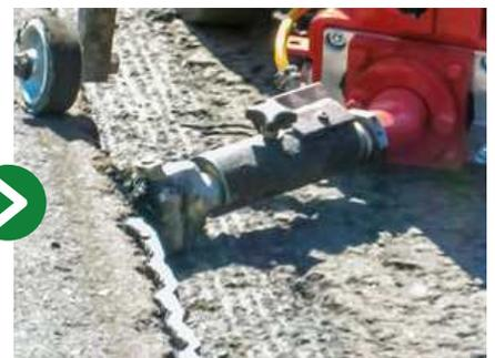
**3** Fugenmasse mit dem TOKOMAT® exakt an die Flanke extrudieren
