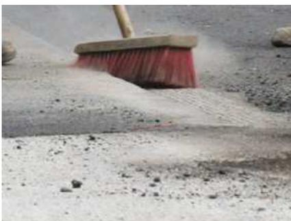
**1** Fugenkante reinigen und ggf. trocknen
