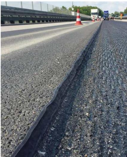
Die TOKOMAT®-Fuge wird in einem Arbeitsgang ausgeführt und – absolut profil- und höhengerecht – direkt an die trockene, vorbereitete Kontaktfläche angebracht. Somit ist die Baustelle nach dem Abschluss der Asphalt-Einbauarbeiten fertig.
